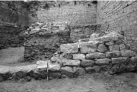
fig. 6 – Il paramento esterno della cinta di XI secolo.
